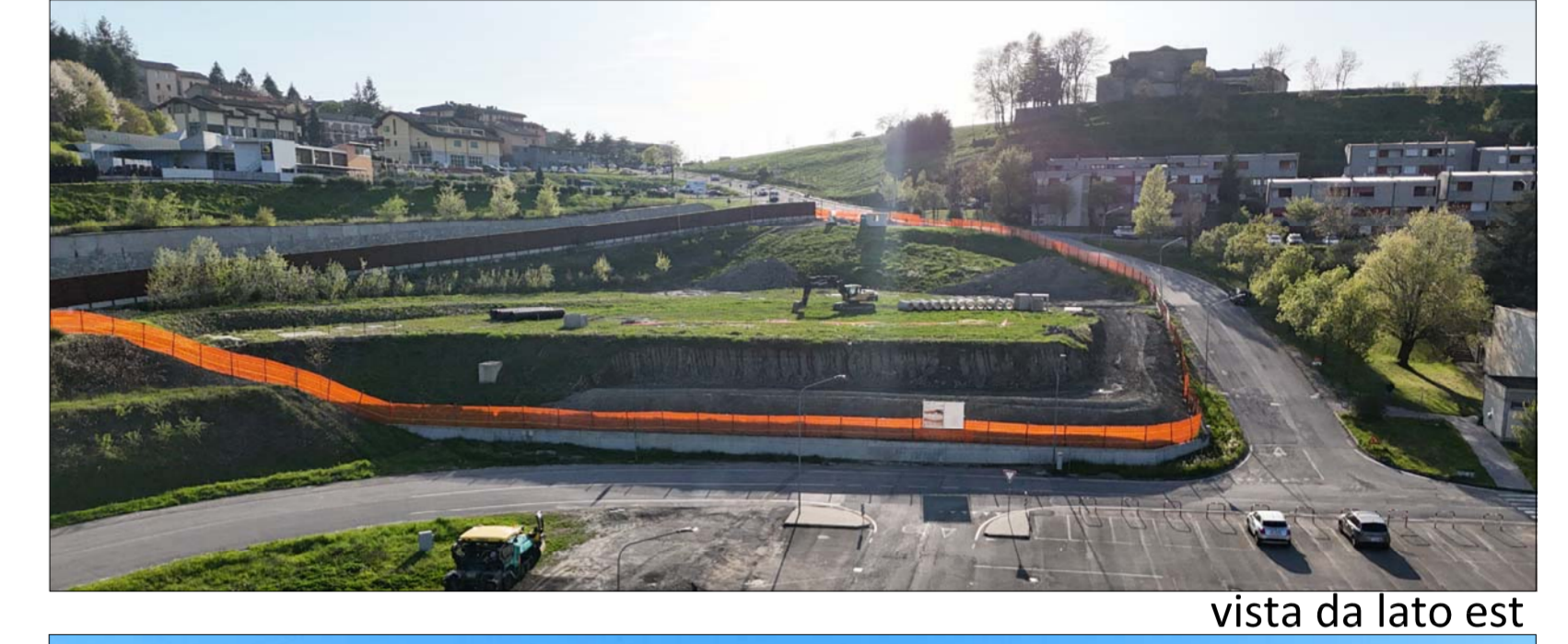
vista da lato est
